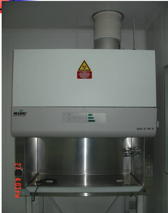
II B型安全柜排风管道的连接
